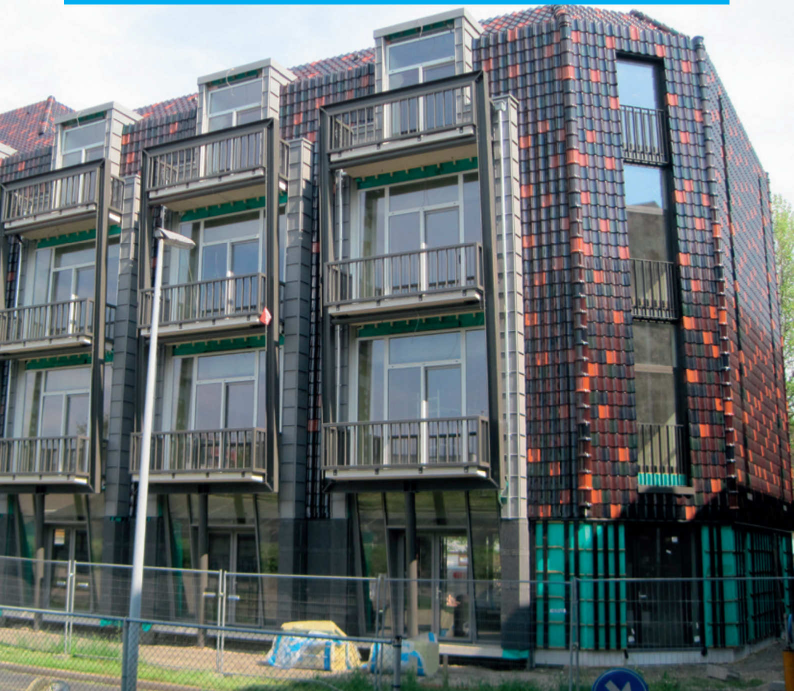
De Hulk, Almere: na transformatie.
